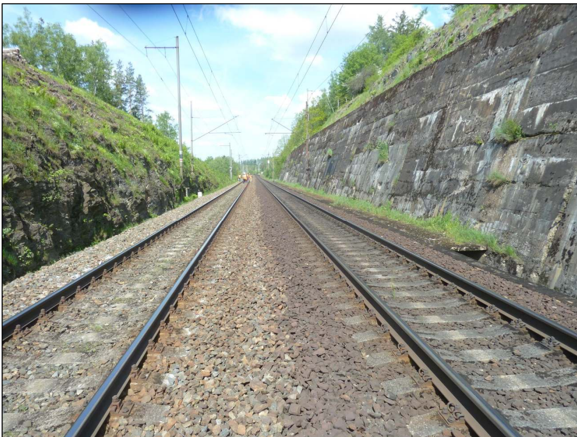
Obrázek 17 – Skalní zářez a zárubní stěna v km 100,550
