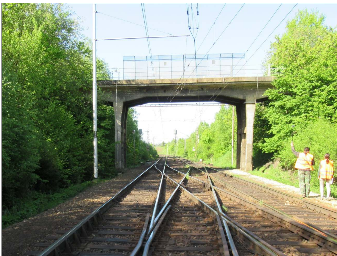
Obrázek 04 – Dvojitá kolejová spojka na přibyslavském zhlaví, nadjezd v km 94,750
