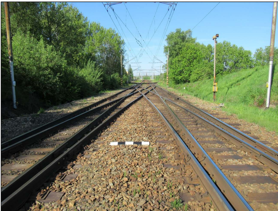
Obrázek 01 – Dvojitá kolejová spojka na žďárském zhlaví
